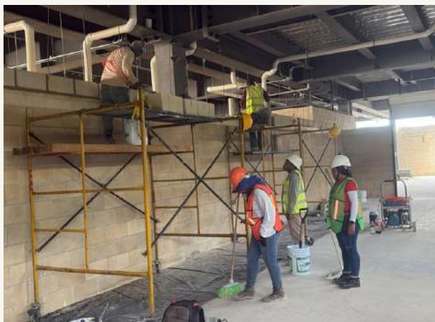
05 • Albañilería y muros divisorios
