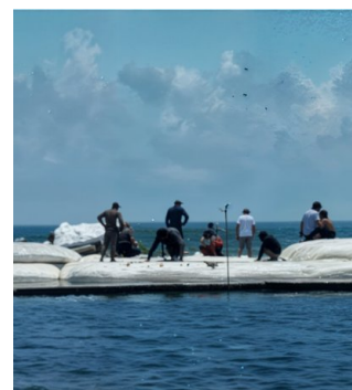
Arrecife de Concreto
